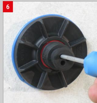
6 Die Gummiabdichtung mit Kreuzschlitzschraubendreher durchstoßen.
