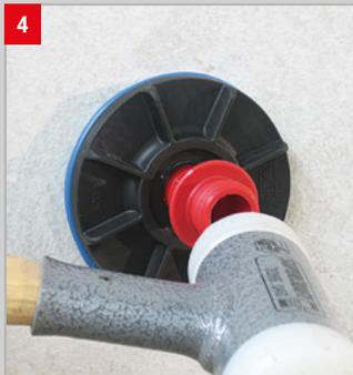
4 Die Spannhülse mittels Kunststoffhammer in das Abdichtelement einschlagen, bis der Flansch der Spannhülse in der Vertiefung des Abdichtelements sitzt.
