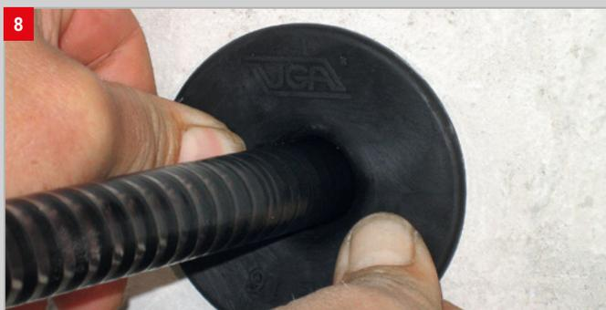
8 Die beiliegende Innen-Abdeckung über den flexiblen Schutzschlauch schieben und in die Bohrung drücken.
