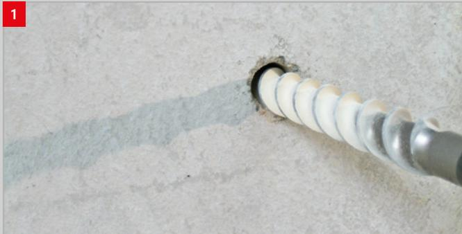
1 Eine Bohrung mit **Durchmesser 25 mm** mittels Schlagbohrmaschine und Steinbohrer herstellen. Falls notwendig die Bohrung an der Außenwand nacharbeiten.
