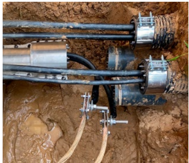
GPD-CV93/G/60/WE50/V2A/EPDM/ (Z)x(D): für die Abdichtung von freiliegenden Wellrohren
