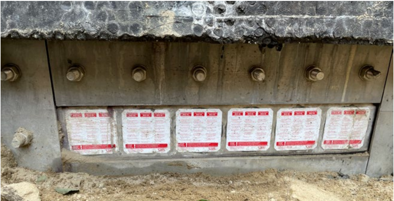
BKD 90 mit Fest- und Losflanschkonstruktion
