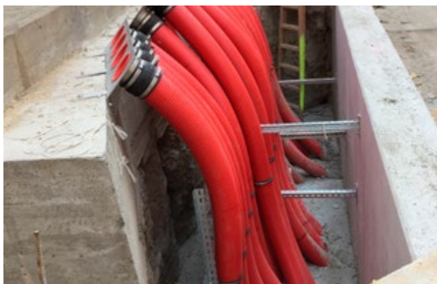
KSS150 mit Anschluss in Manschettentechnik MA(160-170)
