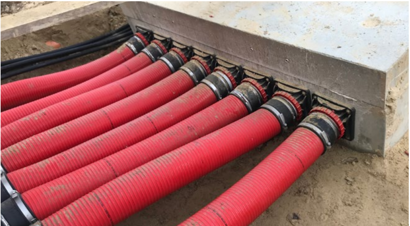
KSS150 mit Anschlussystem BKD150-D-MA
